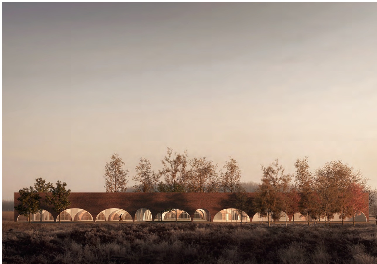
La façade en brique couleur terre a été dessinée pour se fondre harmonieusement dans le paysage.
